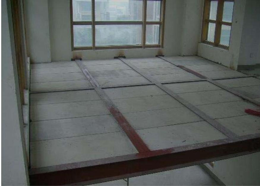
ALC 楼板采用装配式，根据主体结构施工时在预应力梁上事先设置预埋件，由“工”字钢构成结构次梁，工厂生产的 600mm\*Lmm 楼板采用简支板的形式隔置在工字钢上很方便的装配成由 ALC 楼板组合的楼面，由于 ALC 楼板安装节点简单易操作，所以装配速度很快，人均日装配量达到 22 平方米。
