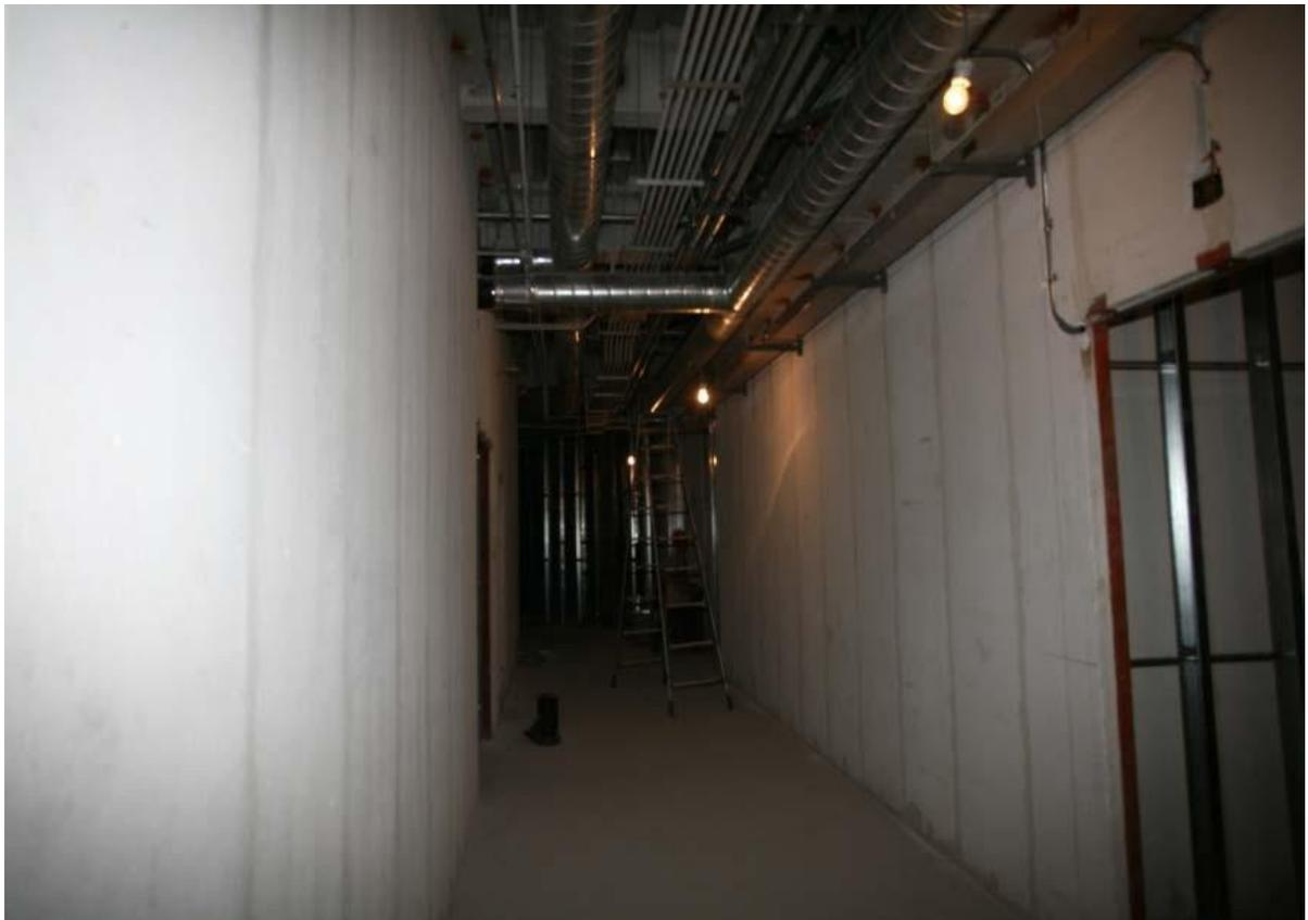
内墙施工相对比较简单，施工后的墙体平整度和垂直度误差均控制在 2mm 以内，装配后的墙体不需要再粉刷，只要批腻子即可喷刷涂料，工人的劳动成本大大减少，人均日装配量达到 10 平方米/天。
